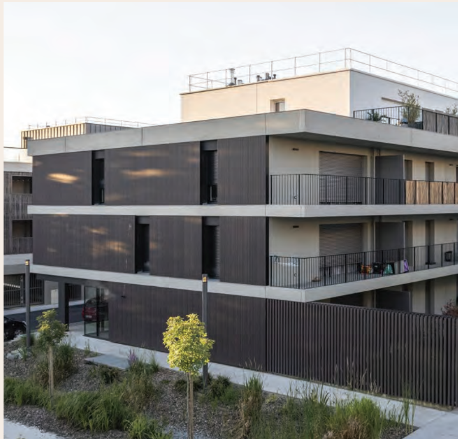
Résidence Garden Square - Vitré (35) - SMART 4 - Colour: Earth • Architect: Chouzenoux Architecture • © Photo credit: Simon Guesdon
