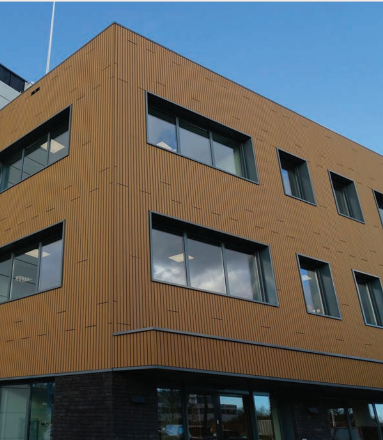
Firmensitz Maasdelta Groep (Niederlande) - COVER 6 - Farbton Sun • Architekt: Groosman Architecten
