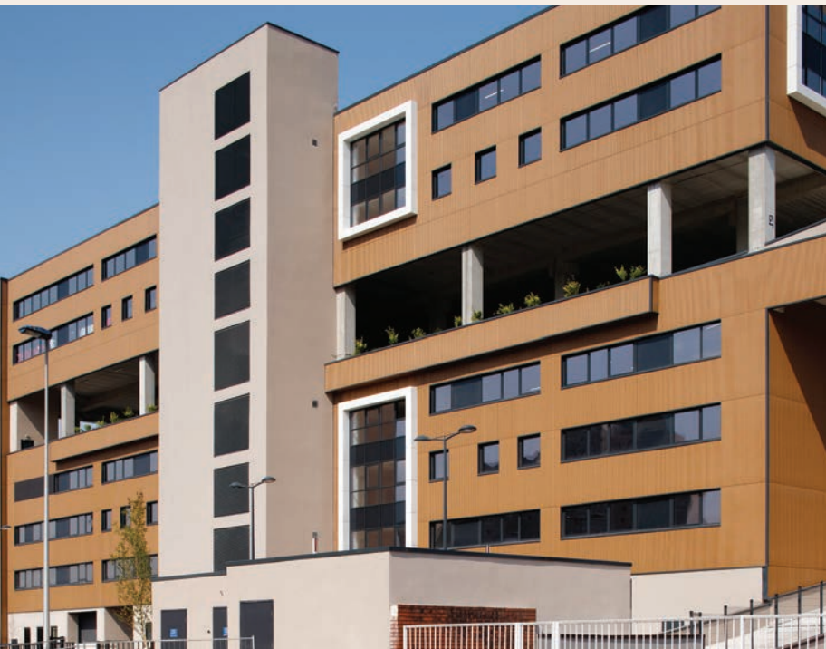
EcoCity Parc - Colombes (92, Frankreich) - CLAD 4 - Farbton SUM • Architekt: MW Architecture • © Bildnachweis: Daniel Moulinet
