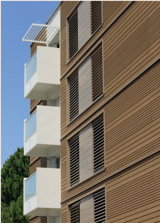
Les Logis de Brunet - La Ciotat (13) - COVER 6 & 14 - Teinte Sun • Architecte : Labastie Architecture • © Crédit photo : Thierry Lavernos - Eiffage
