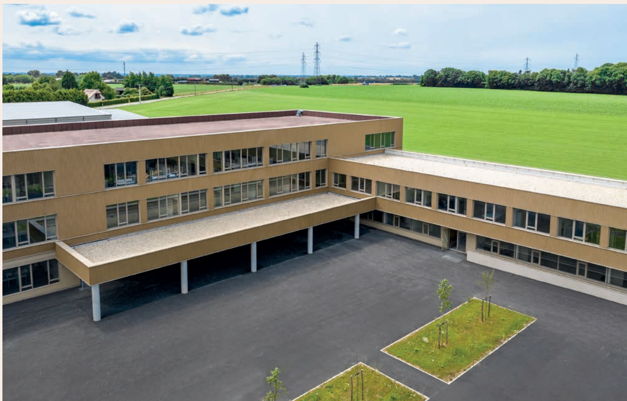
Collège Louise Michel - Bourneville (27) - COVER 6 - Teinte Sun • Architecte : ACAU & AP-MA • © Crédit photo : Initial Ingénierie - Matthieu Lecouvey
