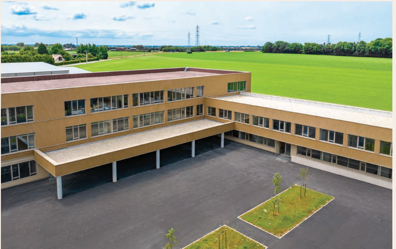
Collège Louise Michel - Bourneville (27, Frankreich) - COVER 6 - Farbton Sun • Architekt: ACAU & AP-MA • © Bildnachweis: Initial Ingénierie - Matthieu Lecouvey
