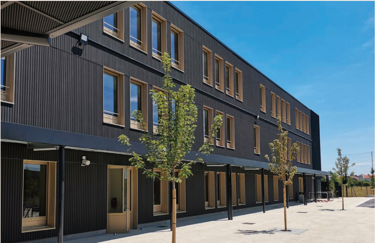
Collège Simone Veil – Saint-Priest (69, Frankreich) – COVER 6 – Farbton Graphite • Architekt: Großstadt Lyon
