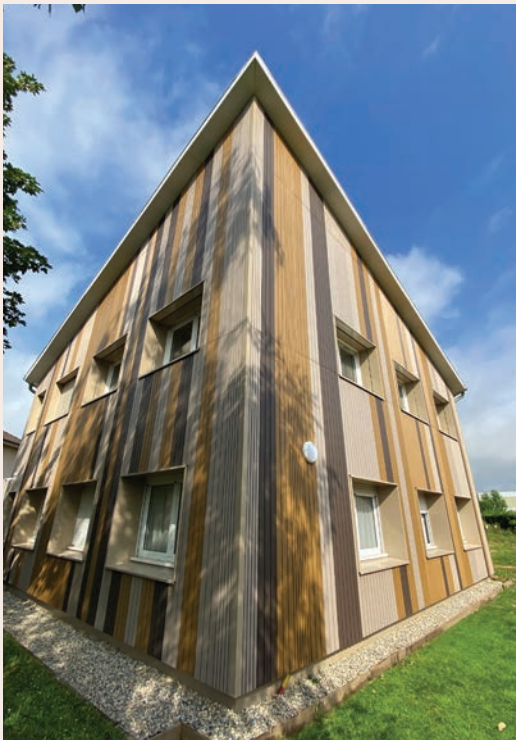
MFR - Moirans (38, Frankreich) - SMART 4 & 9 - Farbtöne Sun, Sand & Earth • Architekt: Dedale
