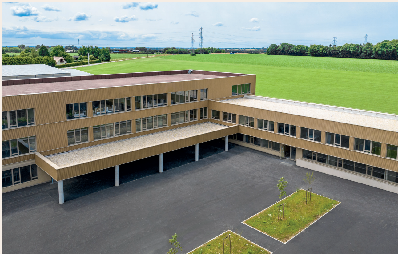
Collège Louise Michel - Bourneville (27) - COVER 6 - Teinte Sun • Architecte : ACAU & AP-MA • © Crédit photo : Initial Ingénierie - Matthieu Lecouvey
